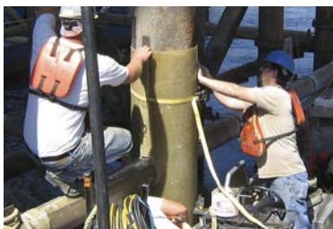
Sistema de protección y reparación de pilotes estructurales FX-70®
