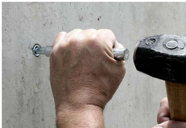
Inserción del anclaje con la herramienta de inserción manual.
